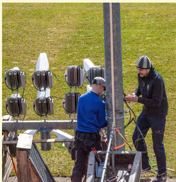
Auch die KM-Spieler packen mit an. Jakob Friedrich und Florian Winkler befassen sich mit der Elektrik.
