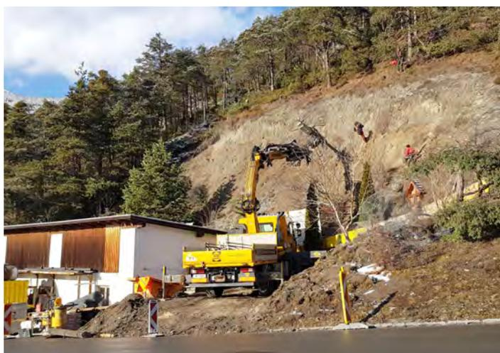
Ein zweites, kleineres Projekt wurde an der Obtarrenzer Landesstraße, im Bereich vom Wohnhaus Trujegasse 24 realisiert. Hier war der vorhandene Steinschlagschutz bereits desolat und nicht mehr zu sanieren. Die Fa. HTB Baugesellschaft m.b.H. aus Arzl hat diesen ausgetauscht.
